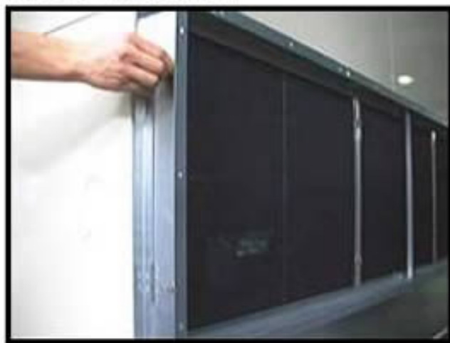
1. 取下回風框(吸氣柵) 空氣吸入口法蘭之左右側均有濾網蓋，只要拆下任何一側鎖緊的翼型螺絲後便可打開濾網蓋。
